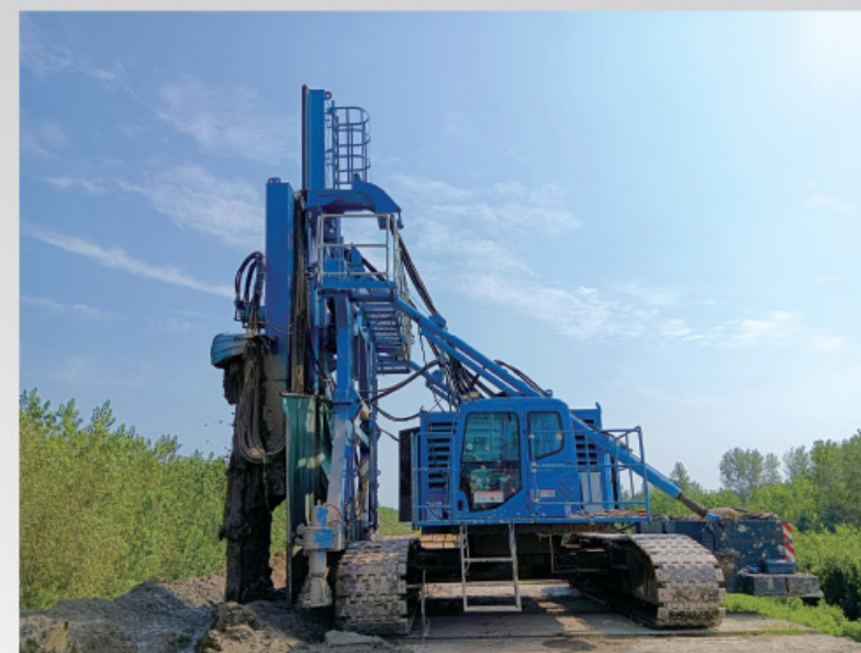
湖南省洞庭湖区堤防加固 施工机型: TRDE7095 / TRD4585
