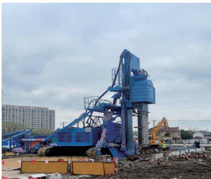
上海浦东孙桥社区雨水泵站工程 槽宽800mm, 深度25米 施工机型: TRD4585 Shanghai Width 800mm, Depth 25m Construction model: TRD4585
