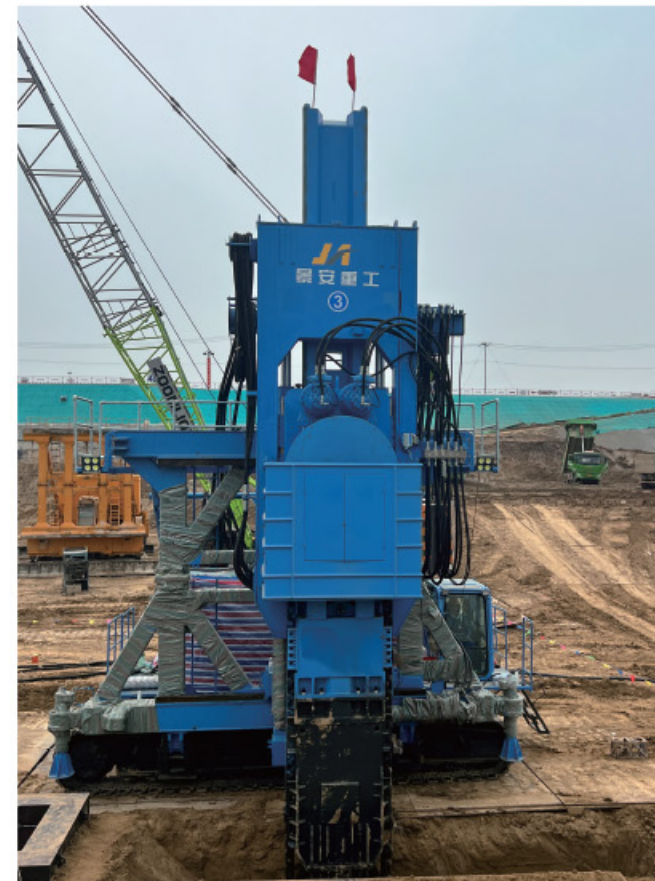
雄忻高铁地下段施工 槽宽800mm, 深度41米 施工机型: TRDE7095 / TRD4585
