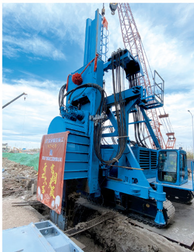
天津北辰施工 槽宽650mm, 深度55米 施工机型: TRD7095
