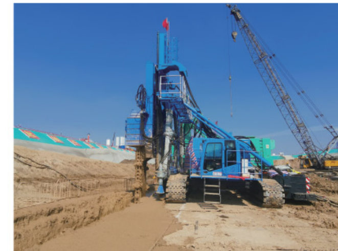
雄忻高铁地下段施工 槽宽800mm, 深度41米 施工机型: TRDE7095 / TRD4585
