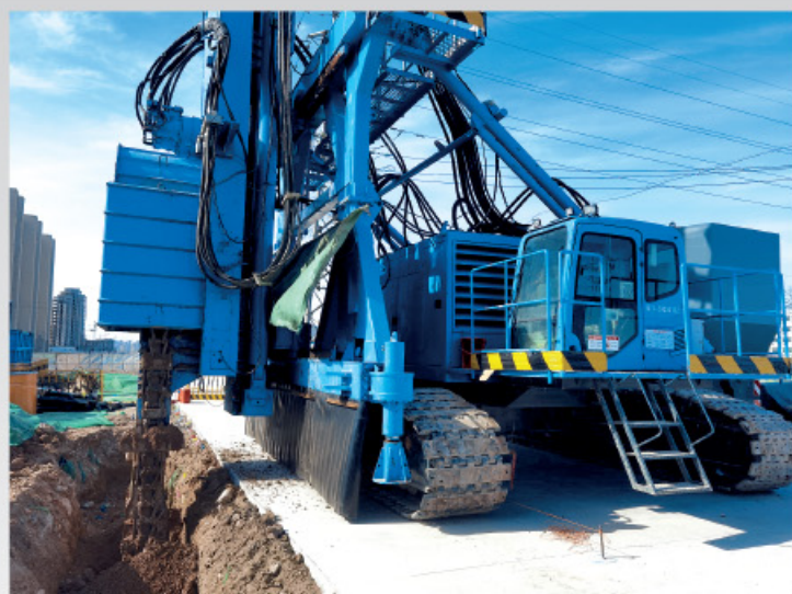
青岛地铁施工 槽宽900mm, 深度45米 施工机型: TRDE7095/TRD4585
