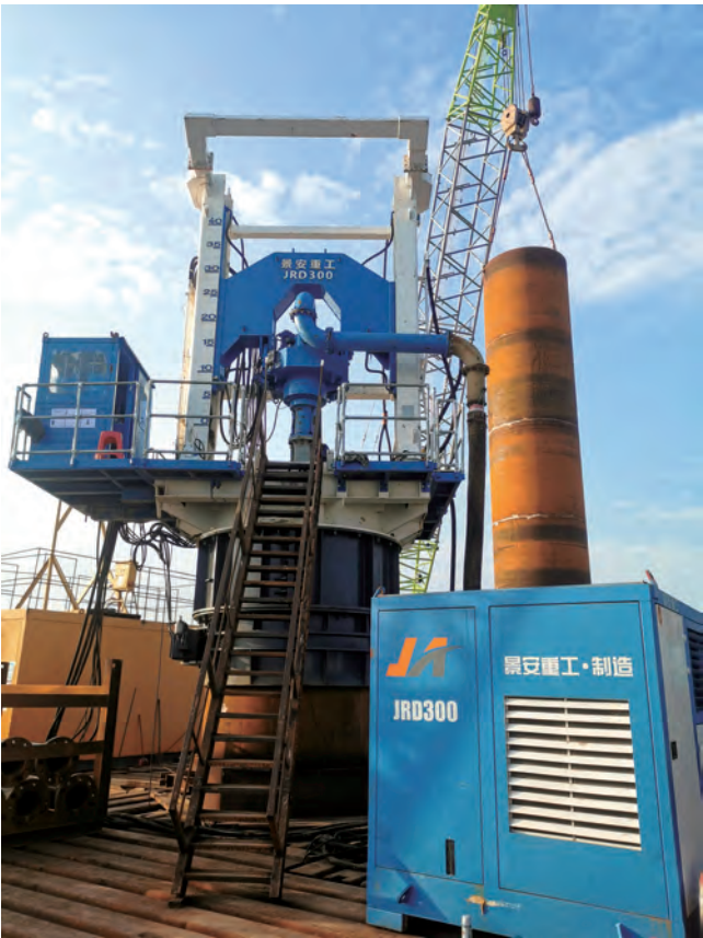
澳砂四桥直径2.8米，深度119米桩基施工
